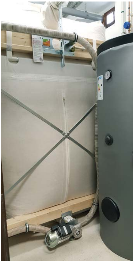
Le silo textile de 5,5 tonnes empêche tout risque de propagation de poussières lors du chargement.
